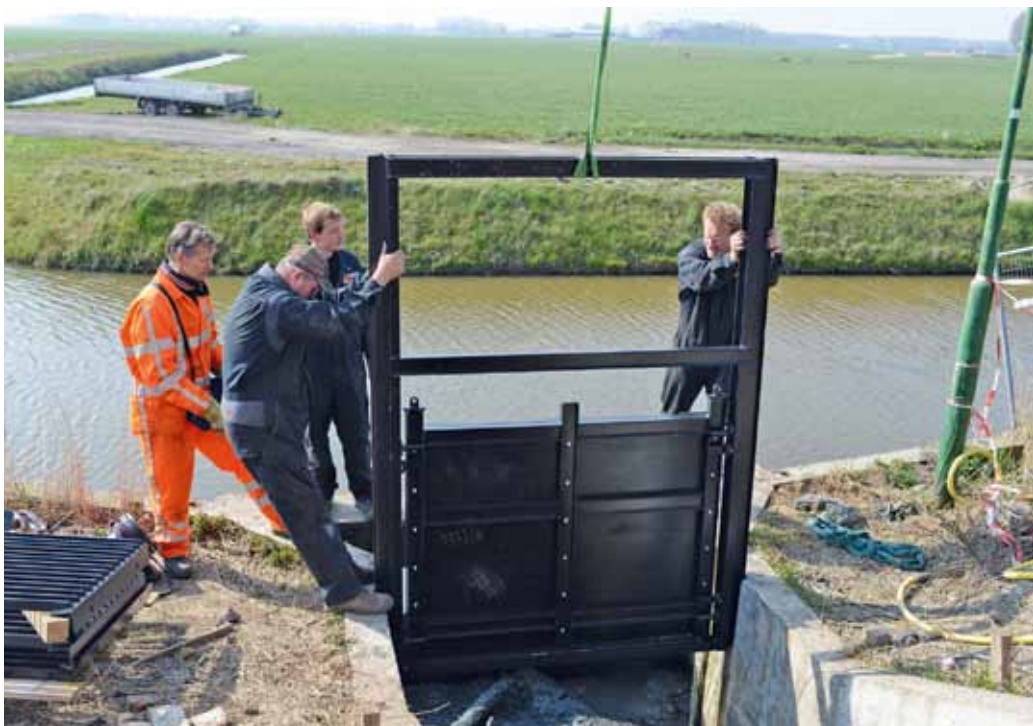
▲ Het 'knijpschot' voor de inlaat wordt geplaatst (foto 28 maart 2014).
