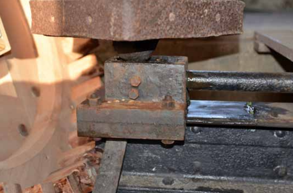
▲ De slede onder de spil om die in en uit zijn werk te trekken (foto 29 december 2014).
