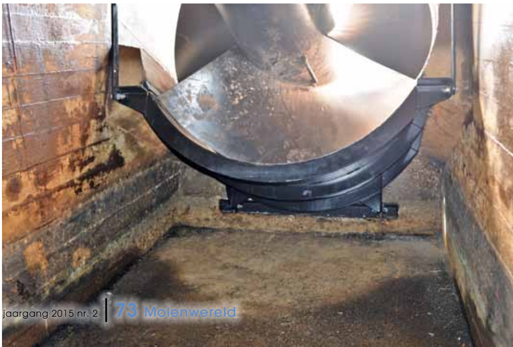
▼ De opmaaklepel aan de bovenkant van de vijzelkom (foto 3 april 2014).
